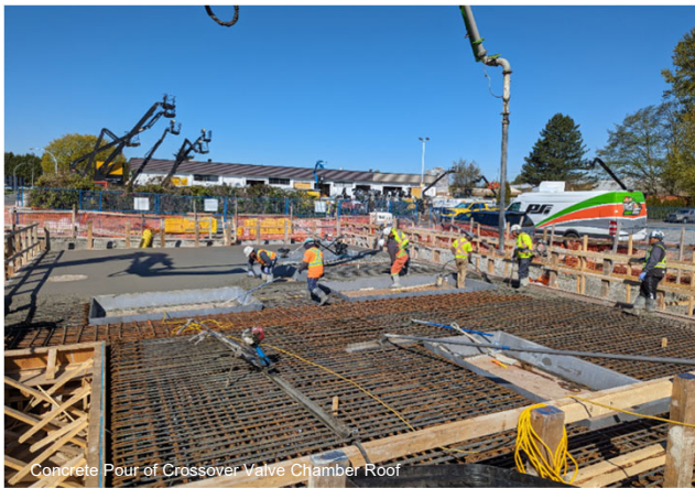
Concrete Pour of Crossover Valve Chamber Roof
